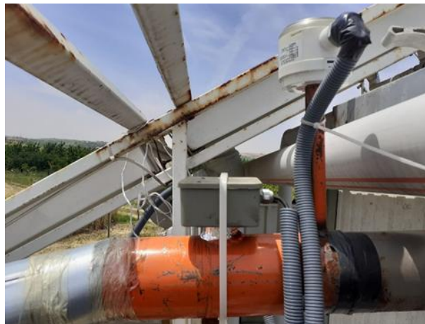
Şekil 2.3. Sıcak hava iletim kanallarına yerleştirilen sıcaklık-nem ve hava hızı sensörleri
